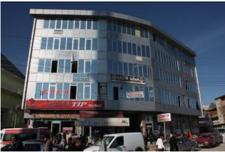
Erciş'te Ağır Hasarlı Olan Tıp Merkezi
