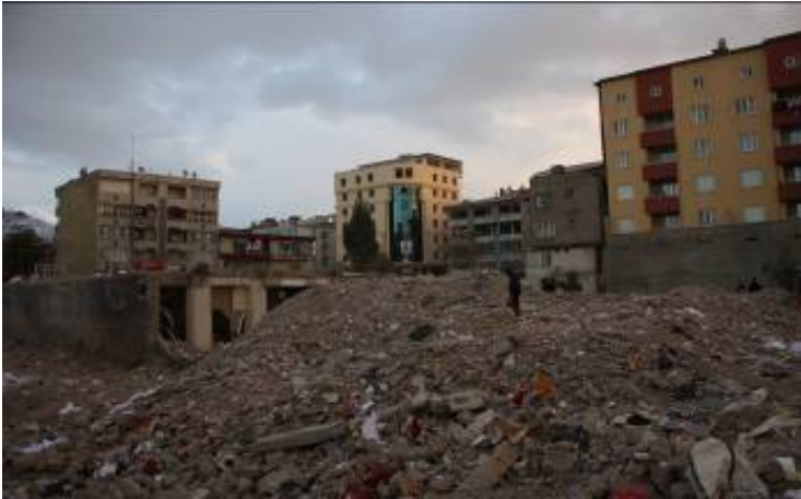
Van Merkezde Yıkılan İş Merkezi
