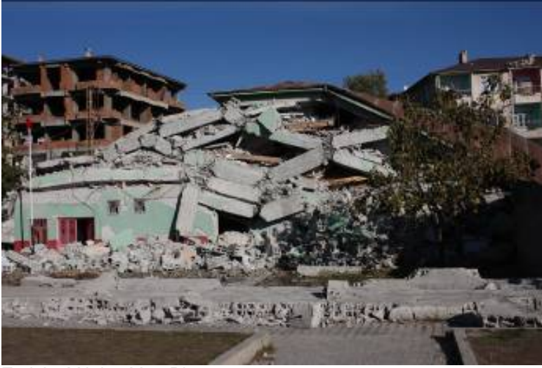
Erciş'te Yıkılan Yurt Binası
